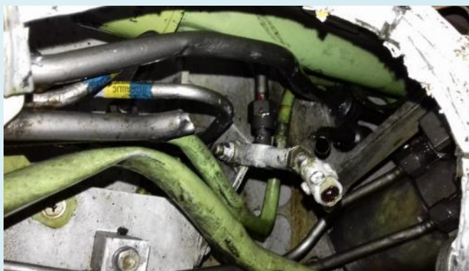
Poškozené potrubí hydraulického systému.
