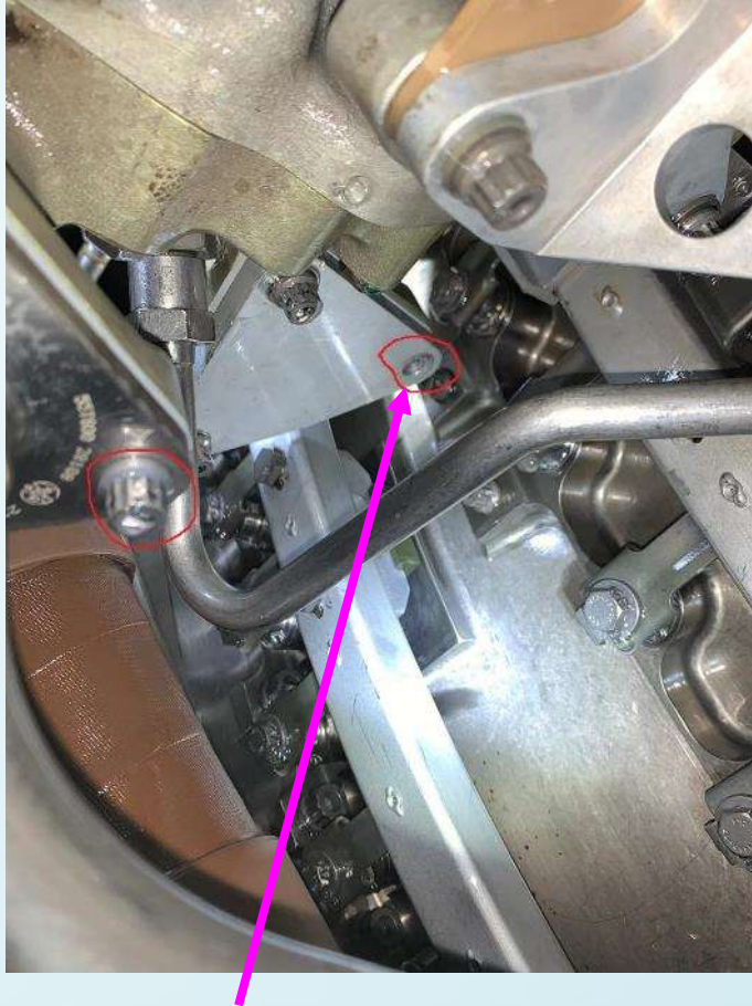
Chybějící šroub na trojúhelníkové záslepce
