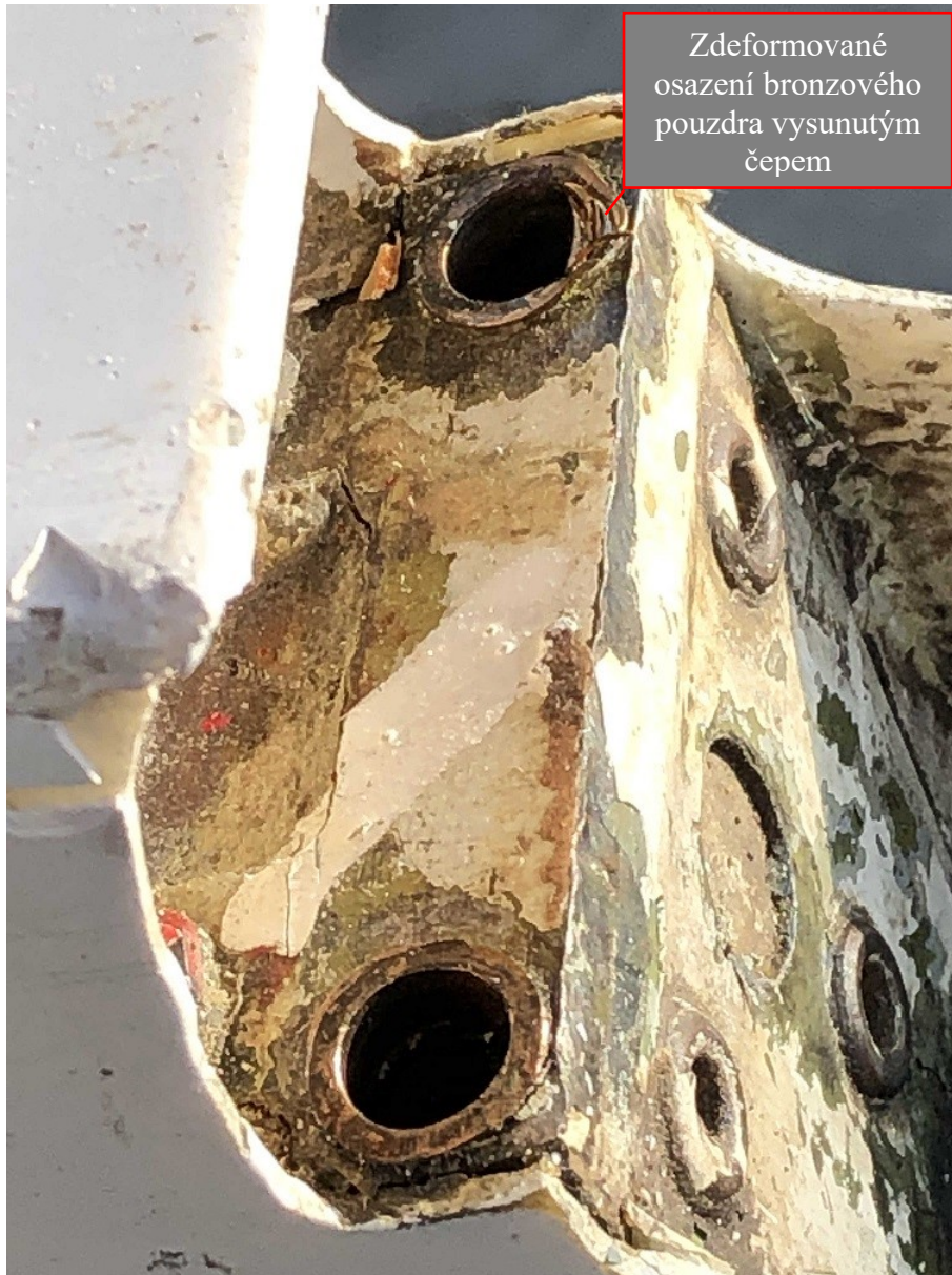
Obr. 9 – Zdeformované osazení levého bronzového pouzdra vysunutým ocelovým čepem konzole
