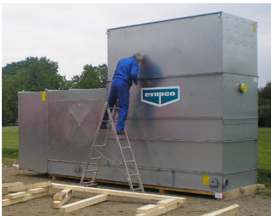
Obr. 1 Příprava kompletu chladicí věže ke vzdušné přepravě na místě uložení
