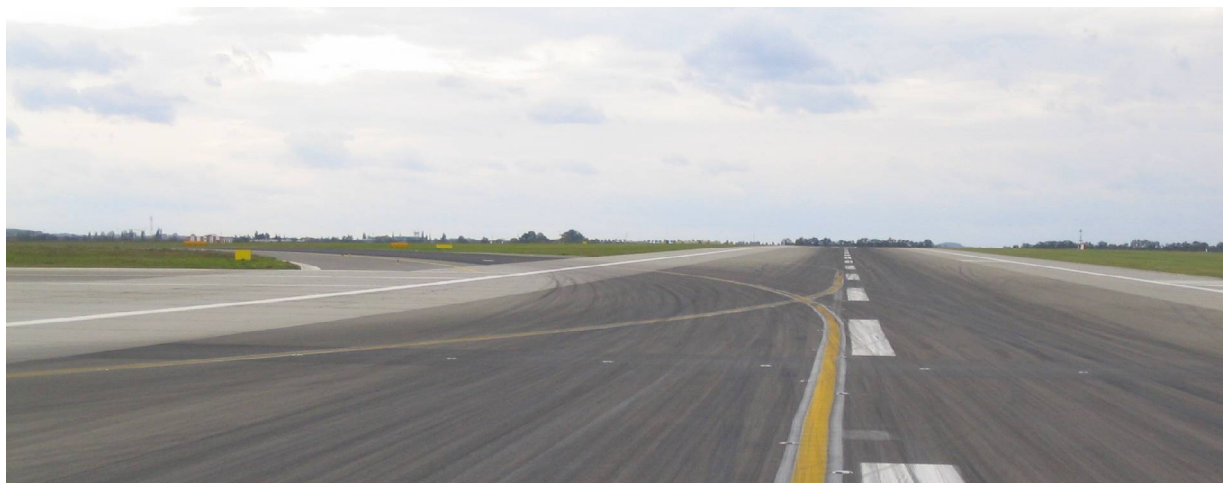
Značení výjezdu z RWY 24 na TWY D (na křížení RWY 13/31 a RWY 06/24)
