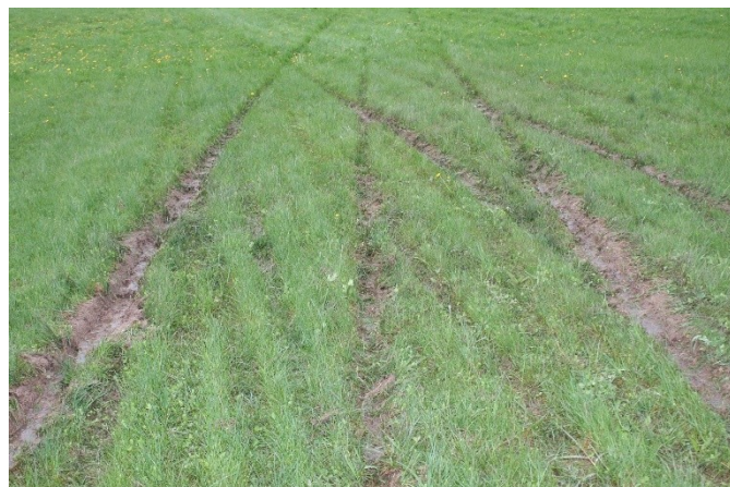
Stopy kol podvozku na rozbahněné RWY
