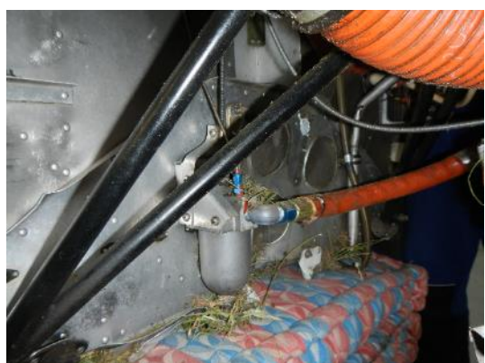
Pohled na poškozenou požární přepážku
