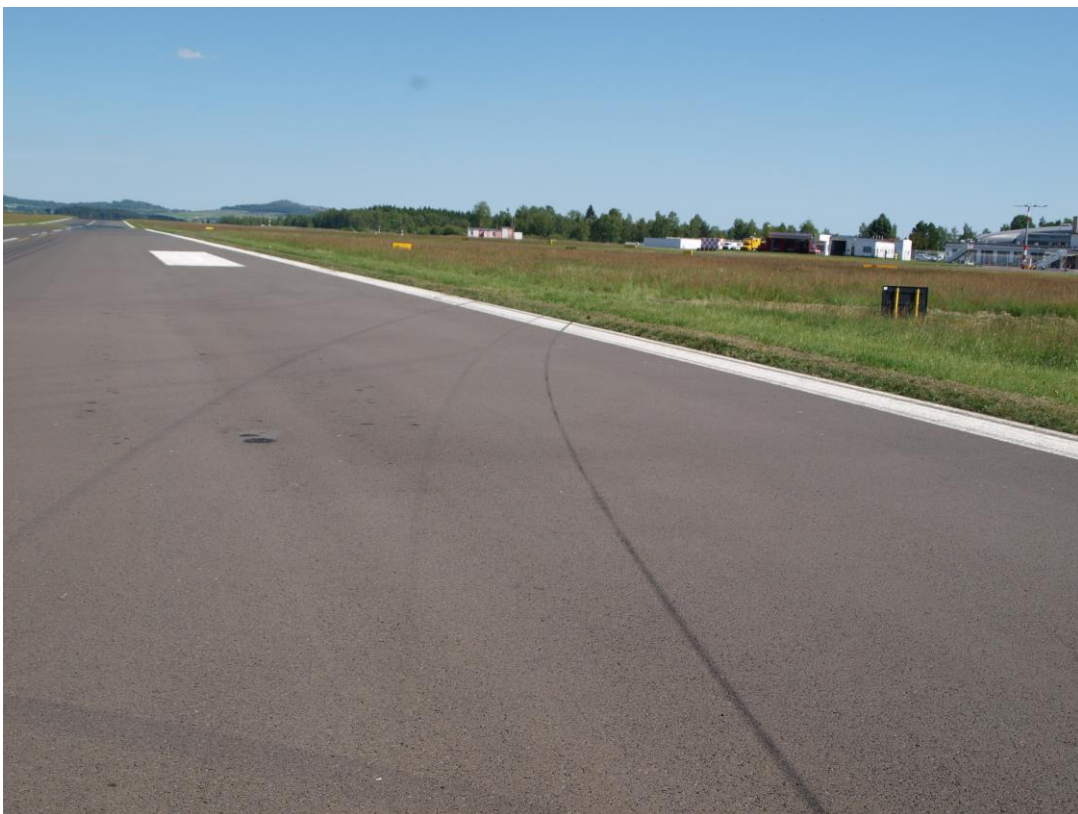
Stopy od kol hlavního a předového podvozku na RWY 11
