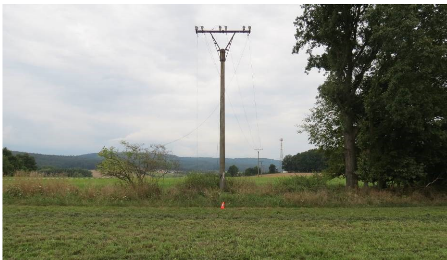
Obr. 3: Poškozené vodiče venkovního vedení VN 22 kV
