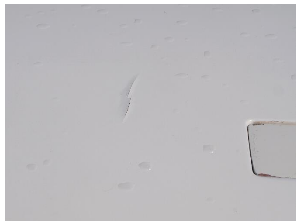
Praskliny na levé polovině křídla
