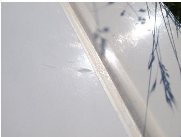
Praskliny na levé polovině křídla
