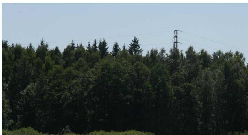
Poškozené venkovní elektrické vedení 22 kV – stožár na pravém břehu
