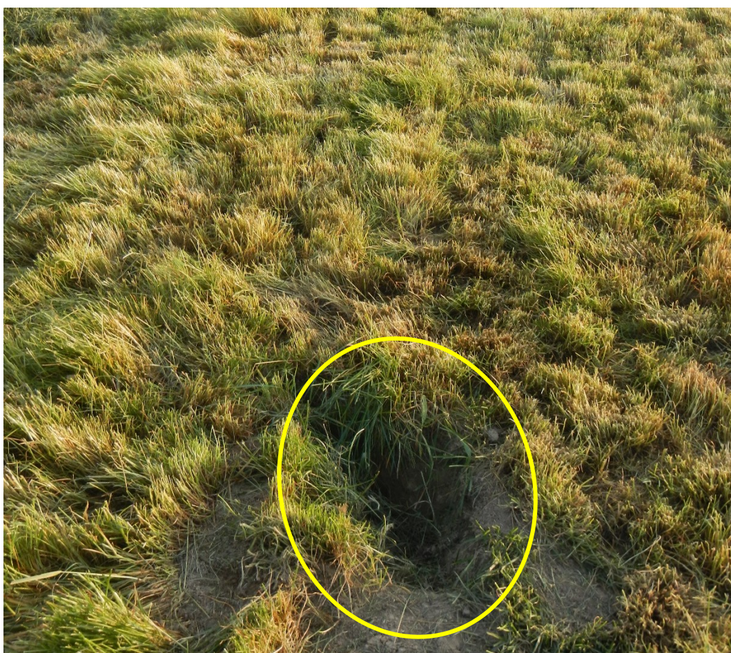
Obr. 3 – Prohlubeň v povrchu plachtařského pásu, do které vjelo levé podvozkové kolo.
