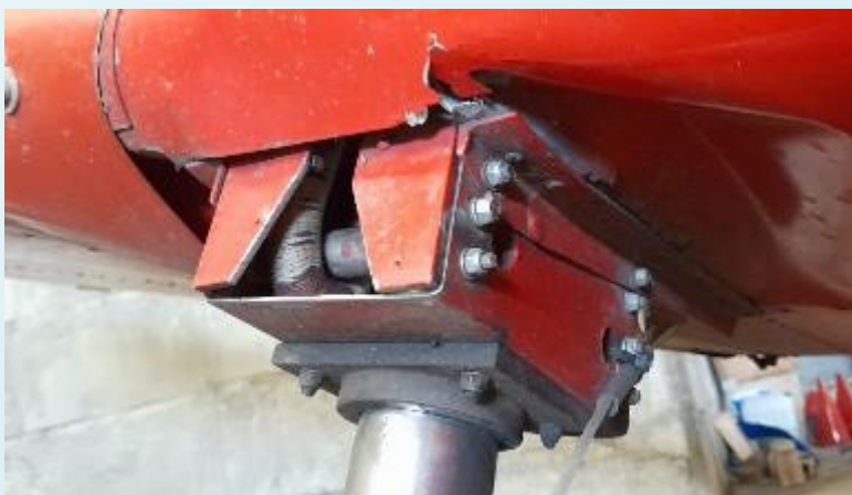
Detail poškození potahu pravé poloviny křídla
