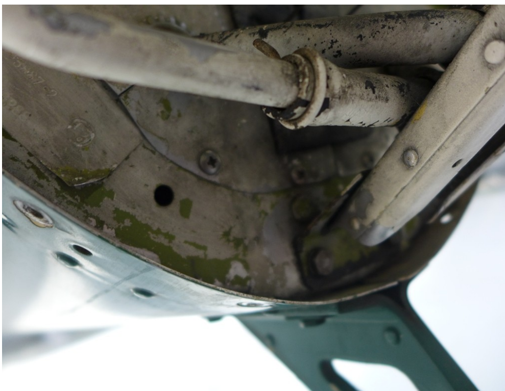
Obrázek č.3 – Poškození uložení podvozku
