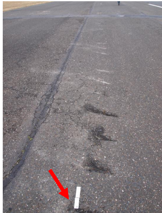
Záseky od vrtulových listů v místě dotyku s dráhou (po odtátí sněhu)
